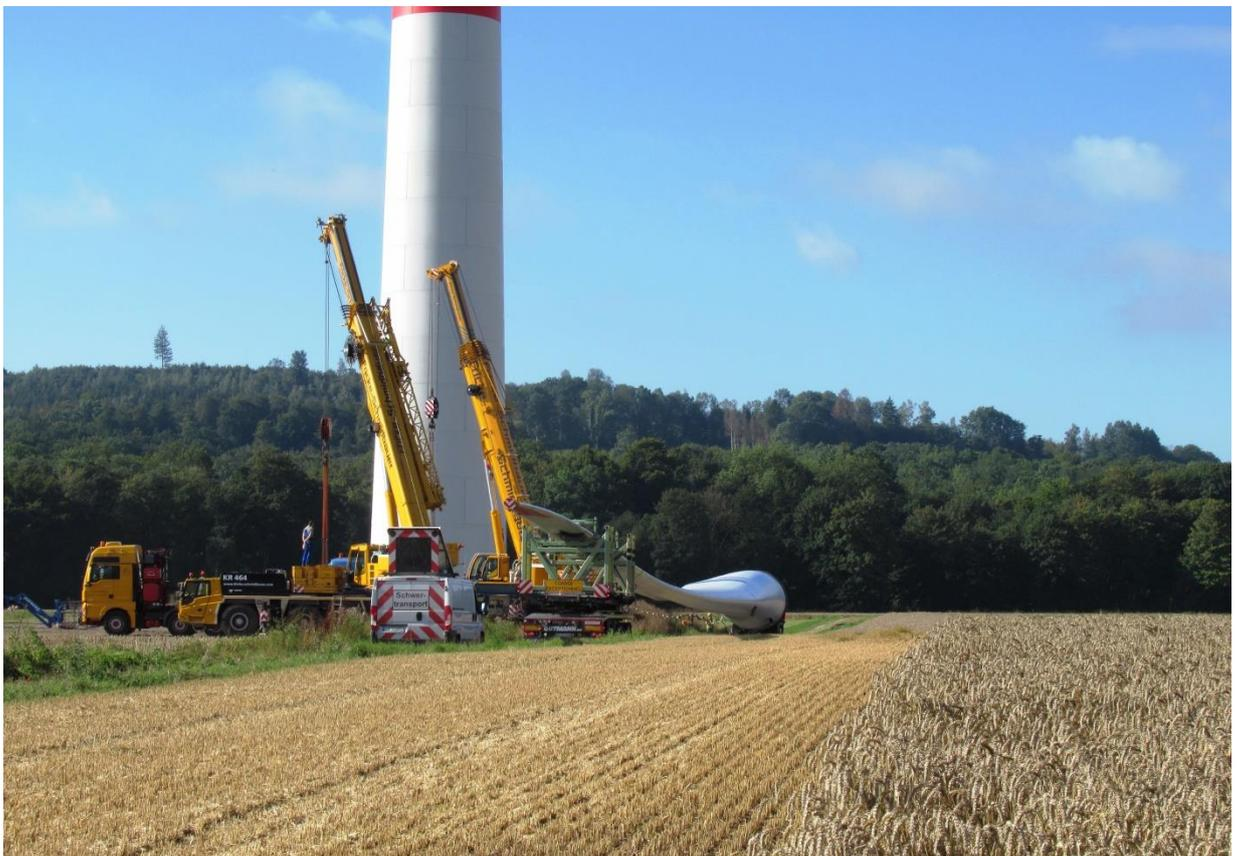
*By the way: Letzte Nacht ist das neue Rotorblatt angekommen. Bald wird ein Kran neben dem Turm aufgerichtet sein. Der Austausch des defekten Rotorblattes dürfte dann in absehbarer Zeit erledigt sein. Kommt Zeit, kommt Strom.*
