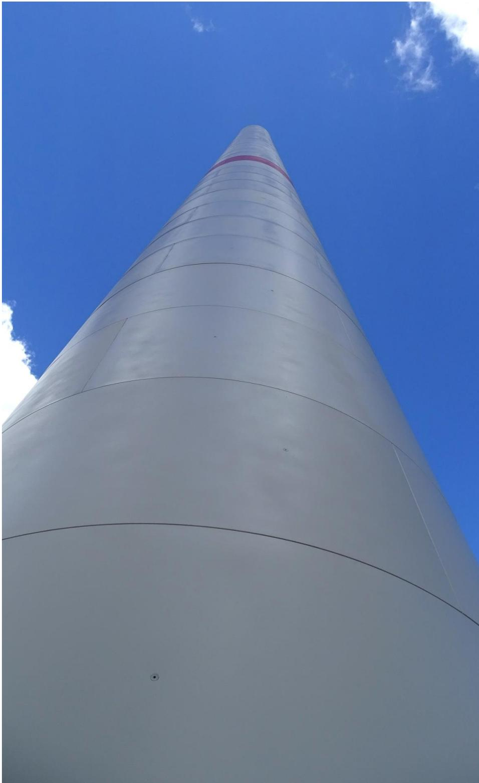
*Die Betonröhre. Segment für Segment auf 85 Meter Höhe passgenau aufeinander gestapelt. Darauf aufgesetzt drei Stahlrohrsegmente. Gesamthöhe Turm: 162 Meter. Glaub mir: Ich zweifelte an mir selbst. Wie soll dieser Turm mit seinen schweren Aufbauten den Kräften der Natur widerstehen? „The answer my friends is blowing in the Wind!“*
