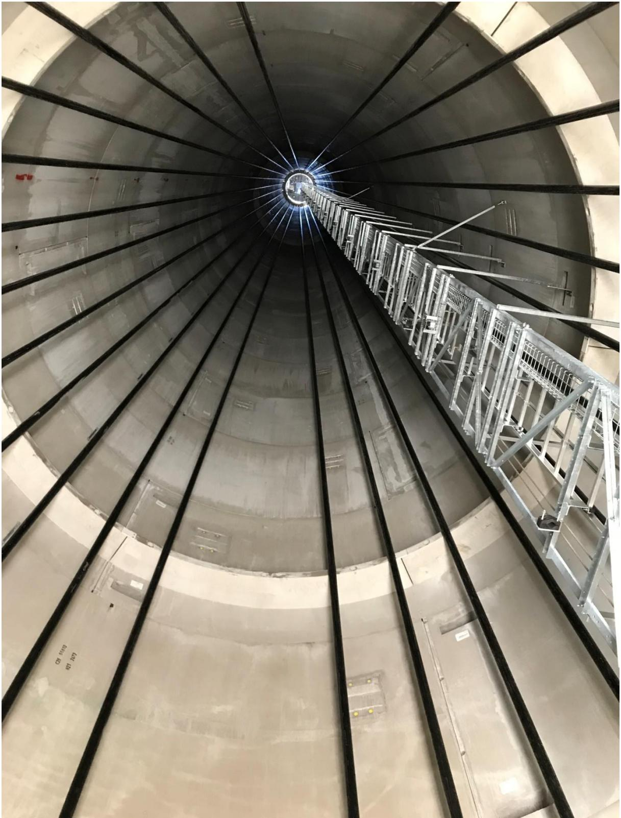
*Im Turm. Die Betonteile sind weder mit Laschen verbunden noch miteinander verzahnt. Der Trick (genial): 24 rund 50 Millimeter starke Stahltrossen halten die Betonteile zusammen. Sie sind eng an der Turmwandung angeordnet. Die Trossen sind mit einer Spannkonstruktion mit den Fundamentankern verbunden und werden auf Spannung gebracht. Diese Konstruktion garantiert auch bei schweren Stürmen ein Höchstmaß an Stabilität der Türme.*
